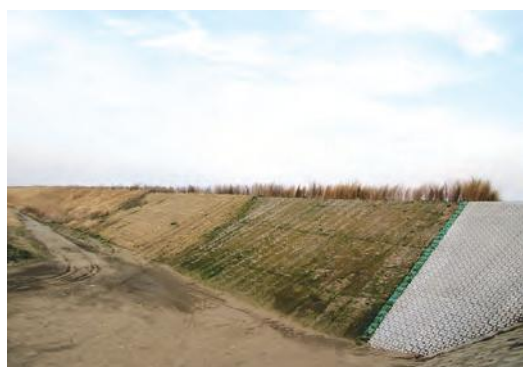
市内で整備が進む防潮堤
