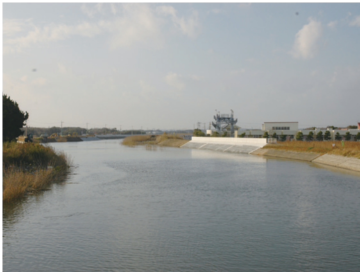
護岸工事が進む木戸川
