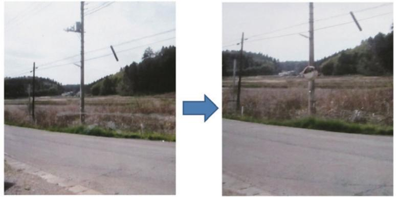
危険なカーブミラーを撤去し、設置し直す
