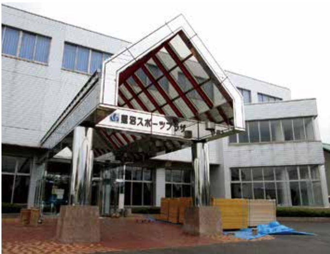
蓮沼スポーツプラザは工事のため平成27年1月まで使用できません (しおさい館・運動広場は使用できます)
