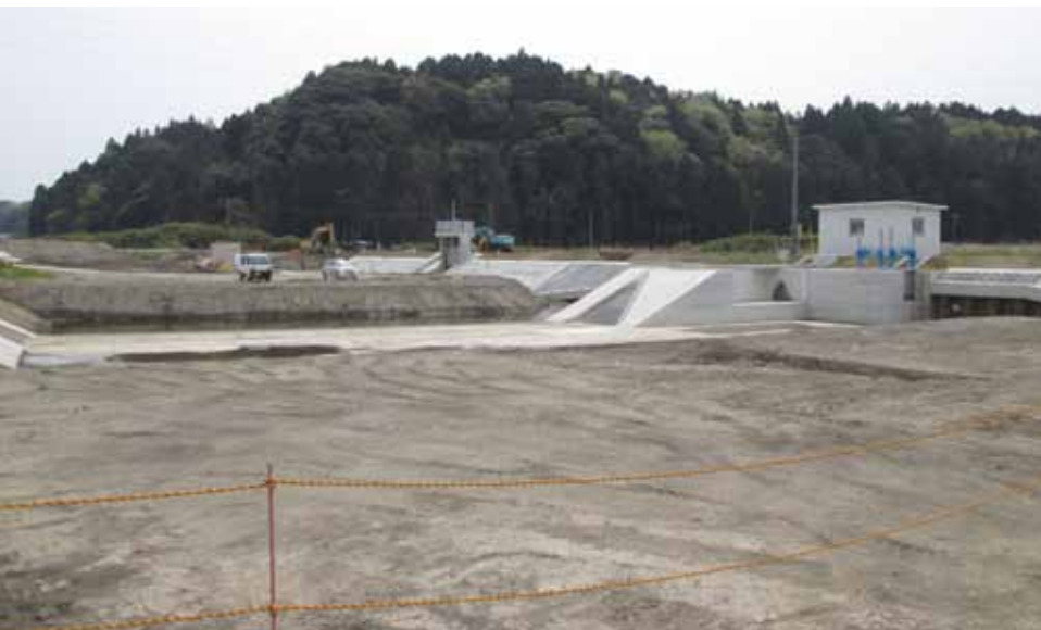
改修工事を行っている成東堰
