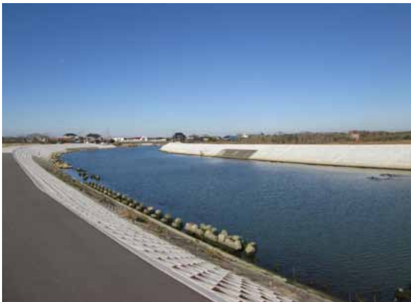
護岸工事が進む木戸川
