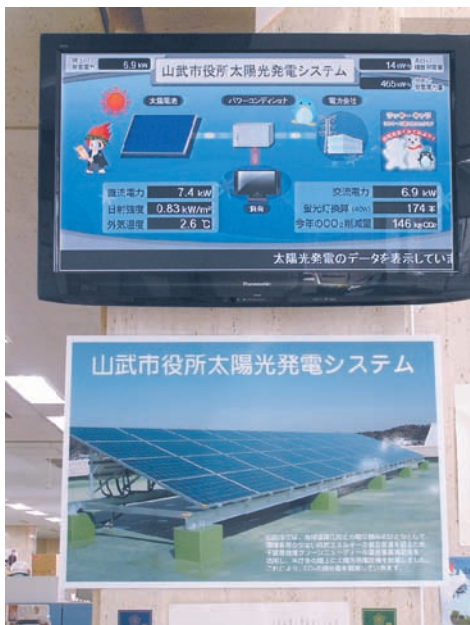
本庁舎屋上に設置されている太陽光発電装置の発電状況
