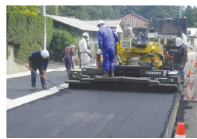
市道の舗装工事
