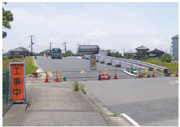
殿台―下町線の橋梁(7月10日撮影)
