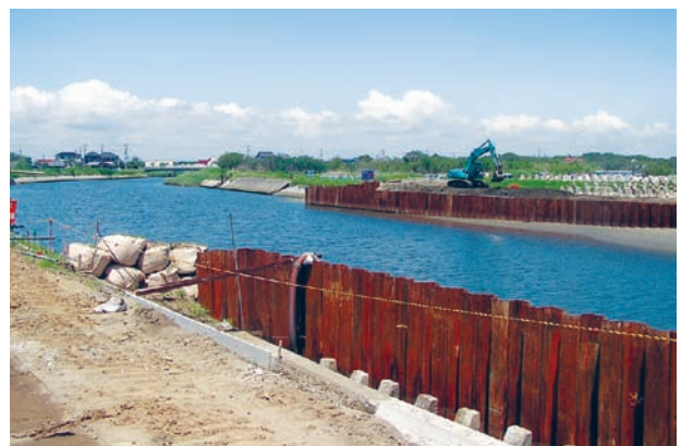
復旧工事の始まった木戸川の堤防
