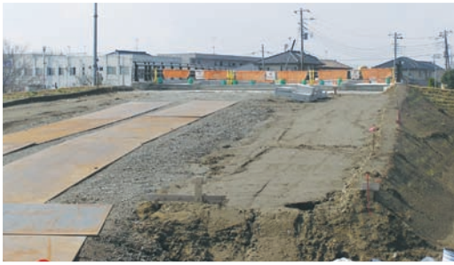
早期の完成が望まれる新しい橋
