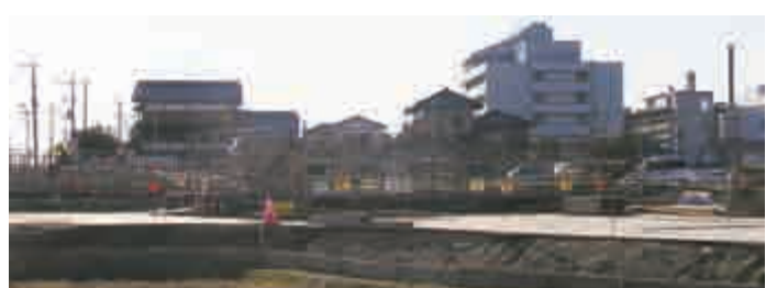
市役所前作田川橋梁工事
