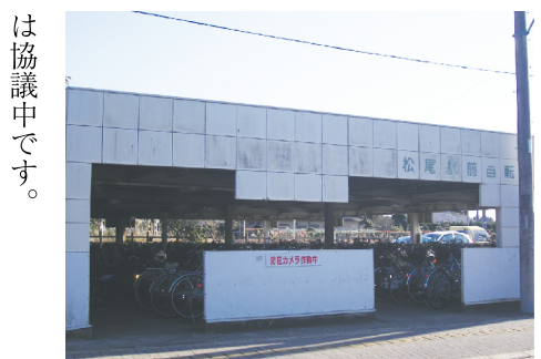
松尾駅前自転車駐車場
