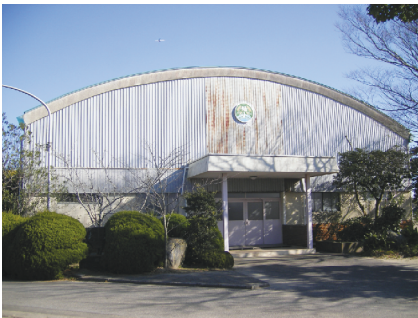
緑海小学校体育館
