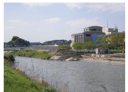
作田川改修工事（成東工区）
