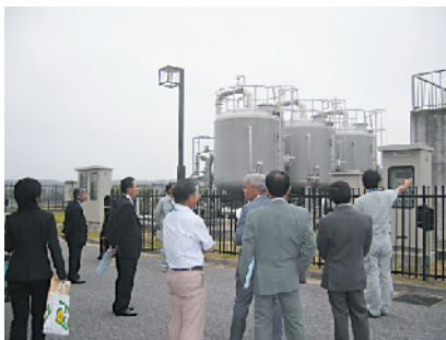
山武浄水場を視察する川南町議会議員
