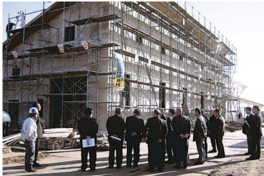
大平地区農業集落排水汚水処理施設を視察 (3月7日)
